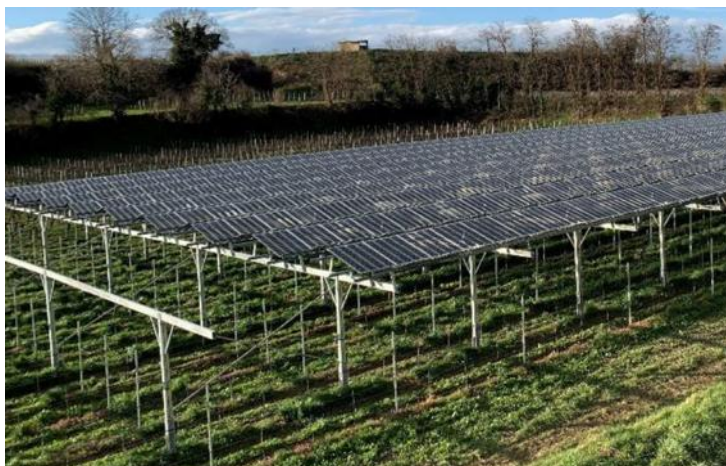
Abbildung 13: Beispielfoto für eine hochaufgeständerte Agri-PV-Anlage; Quelle: Viridi Re GmbH
